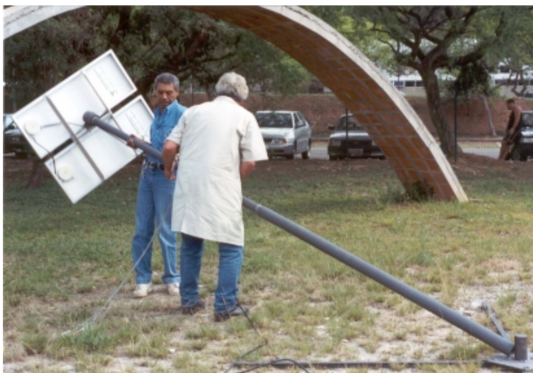
Foto 77 – Fixação do poste.
