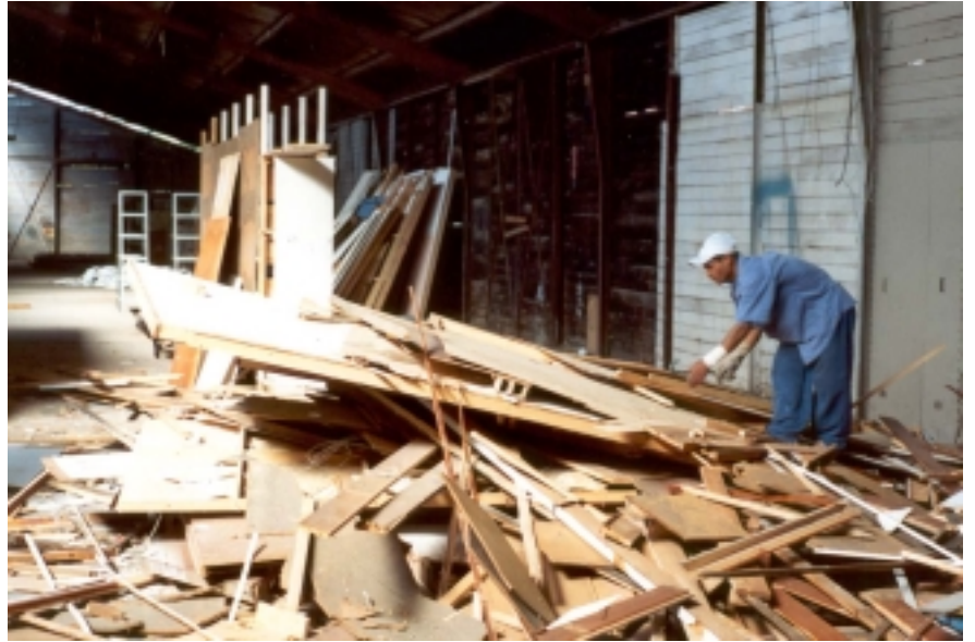
Foto 96 – Início da desmontagem - material antes da separação.
