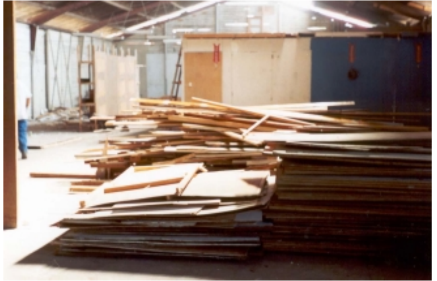
Foto 101 – Materiais separados, compensados.
