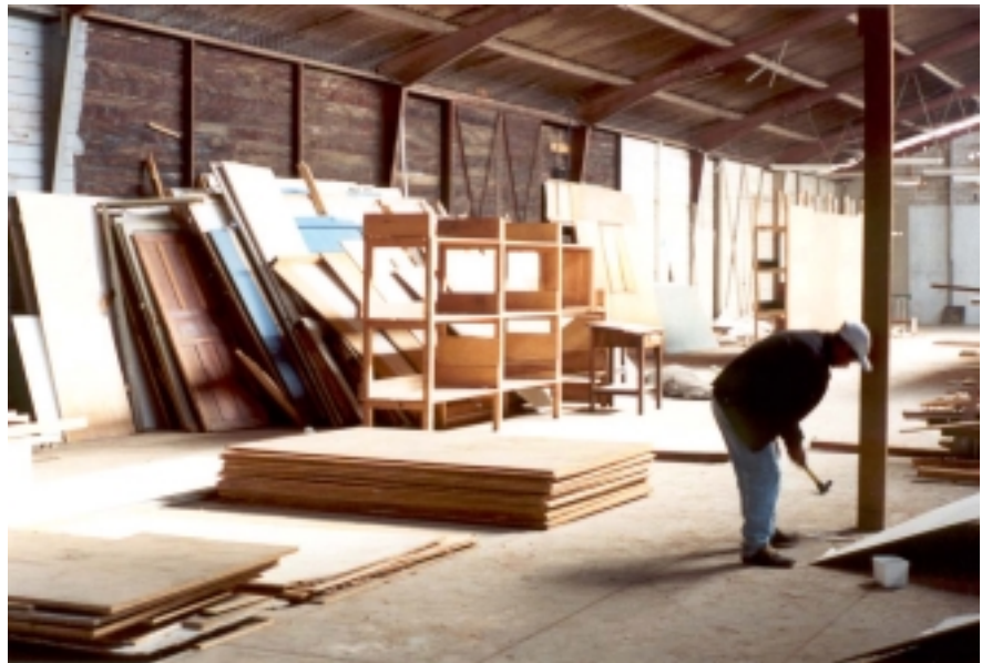
Foto 97 – Vista interna do galpão com a desmontagem já iniciada. Observar os materiais já sendo separados: chapas de compensado, armários velhos, painéis de madeira, etc.
