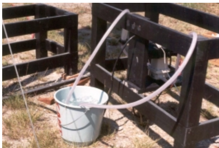
Foto 80 – Fixação da bomba d'água.
