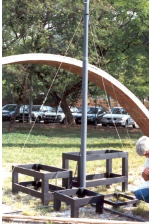
Foto 78 – Colocação dos suportes das caixas.
