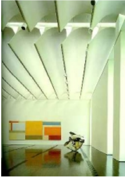
Fotos 28 e 29 - The Menil Collection Museum, de Renzo Piano. Ilustra a utilização de elementos estruturais para auxílio na captação da luz natural. As peças da estrutura da cobertura foram especialmente projetadas para este museu. A estrutura do edifício utiliza madeira e vigas metálicas. Foto extraída da revista AU – Renzo Piano – Building Workshop 1964-1988 (edição extra).
