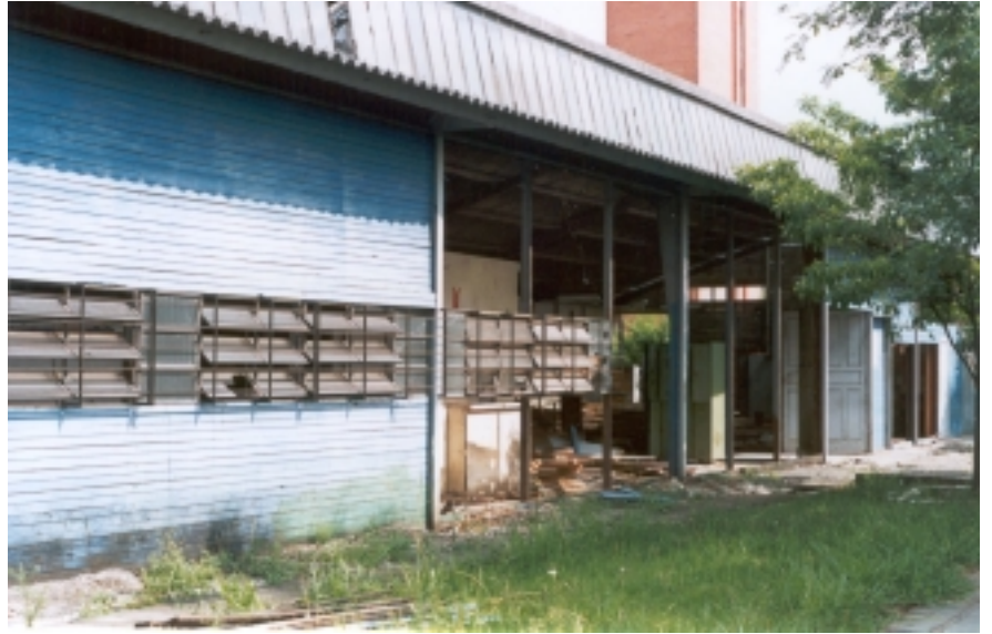
Foto 107 – Retirada revestimento externo (2).
