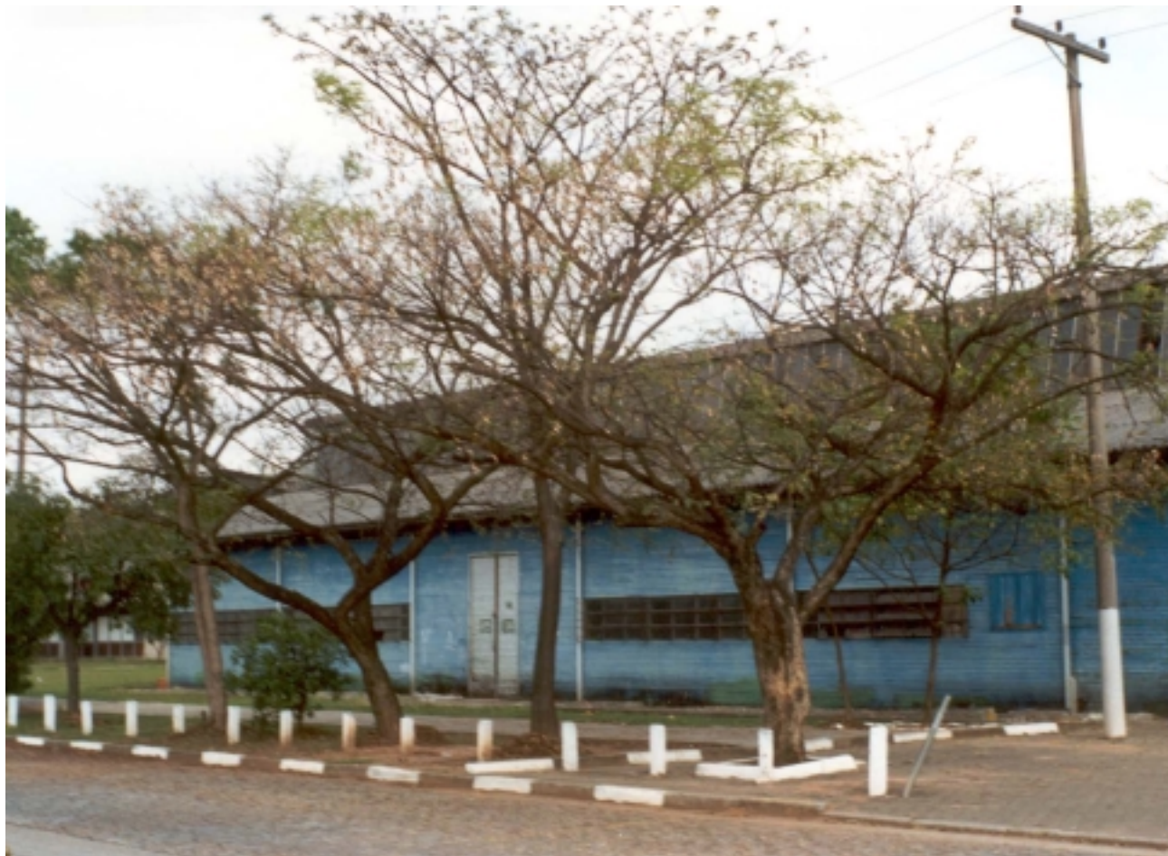
Foto 94 – Vista galpão antes de iniciar o processo de desmontagem.
