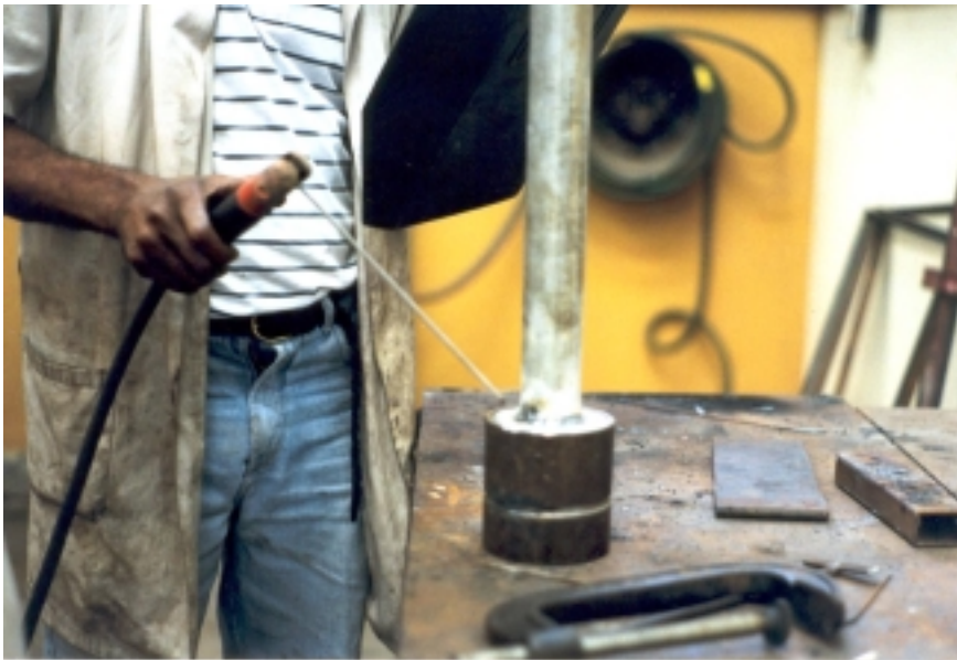
Foto 66 – Encaixe do suporte do painel solar na haste. Tarugo sendo soldado no segunda haste do poste.
