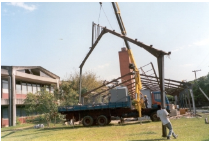
Foto 112 – Desmontagem estrutura metálica (2).
