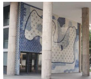
Entrada do Edifício Gustavo Capanema
