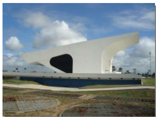
Centro de Convenções da UENF
