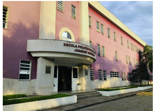
Figura 6 - Fachada da escola.
