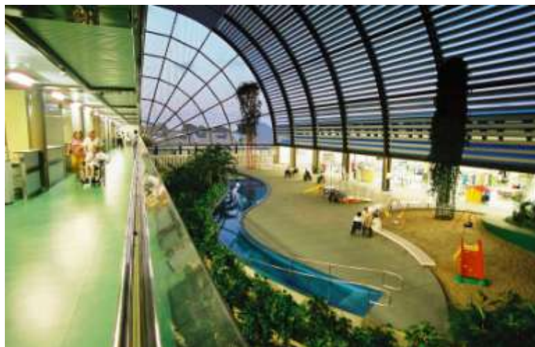
Figura 12: Tratamento da área externa no hospital da rede Sarah Fonte: http://www.sarah.br/a-rede-SARAH/nossas-unidades/unidade-fortaleza/
