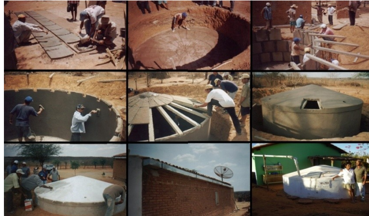
Ilustração 10: Processo de construção da Cisterna através de placas pré-moldadas curvadas.
