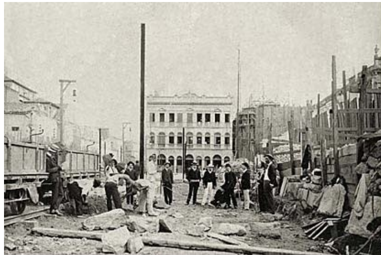
Figura 2: Demolição para construir a Av. Central, 1904-1905 (Autor: João Martins Torres).
