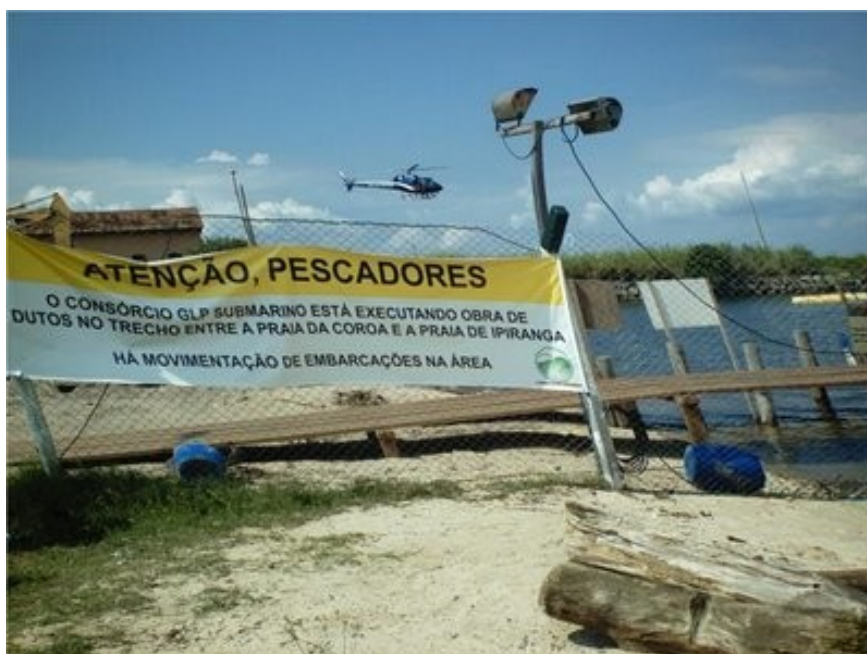
Figura 18 – Aviso da Petrobras sobre a instalação dos dutos em 2009.
