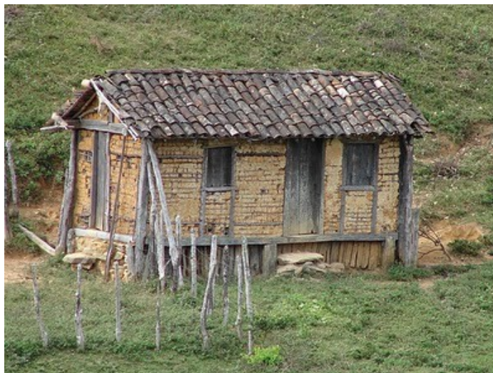
Figura 8: Casa de pau-a-pique
