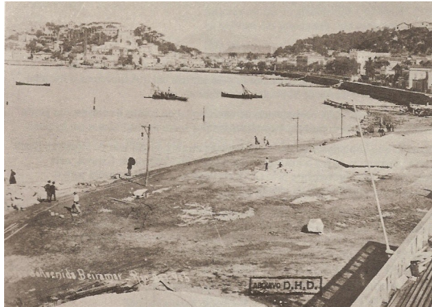
Fig. 3.8: Obras da Avenida Beira- Mar. Foto Malta, 1905. Arquivo Geral da cidade do Rio Janeiro. (In: DEL BRENNNA, 1985).
