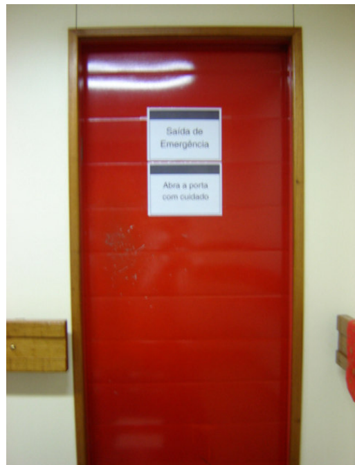
Figura 17 – Saída de emergência
