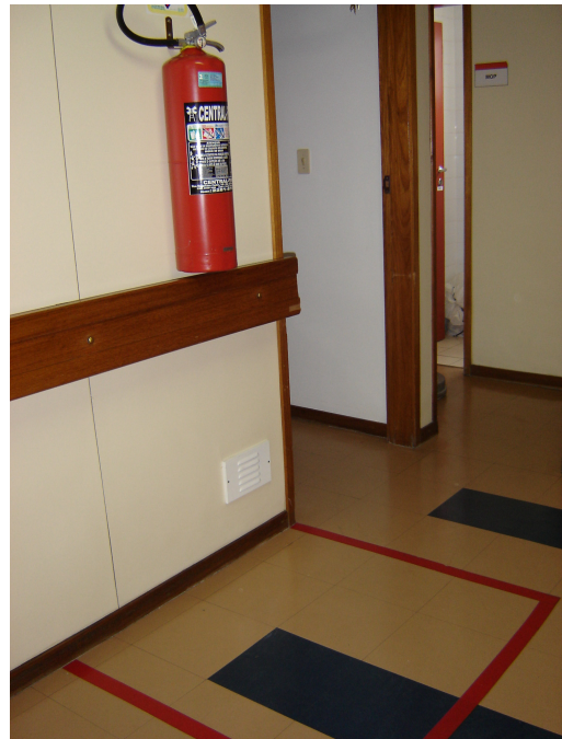
Figura 15 – Faixa no chão indicando o extintor de incêndios
